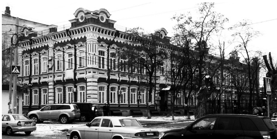
Здание на улице им. Огарева, в котором облИУУ располагался с 1958 по 2000 год.
