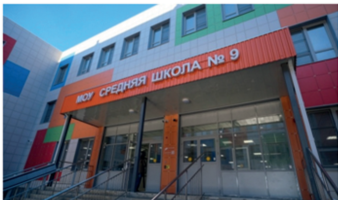
Фото 2. Центральный вход в здание школы
