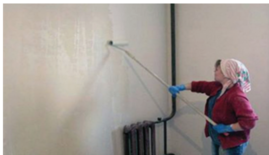
Рис. 7. Нанесение грунтовки с помощью валика
