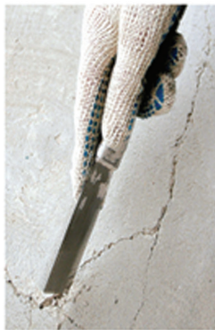
Расшивка трещин.
