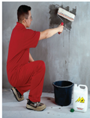
Грунтование поверхности
